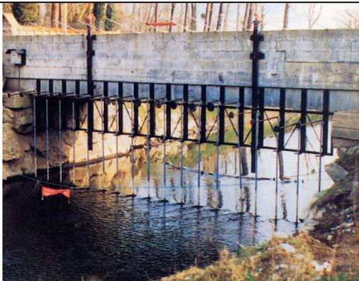
電気スクリーン方式は、魚類の体内を電気が通過することにより、忌避行為を促すものである。
