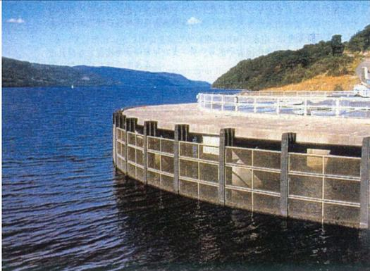
格子スクリーンは、魚類が通り抜けできない目合いの格子状のスクリーンを取放水口前面に張り、迷入を防止するものである。あまり目合いを細かくするとゴミの付着等が発生する。
