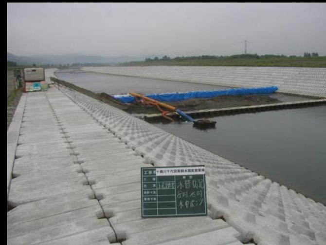
締切・水替状況（沈砂池からの土砂搬出）
