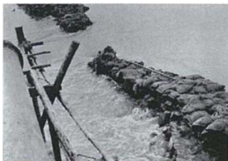
決壊口の両側を石俵で補強 (S34伊勢湾台風)
