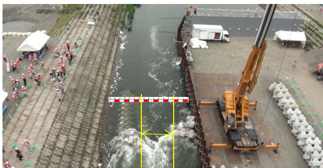
(d) 開口幅約6.5m( 25個投入)
