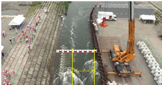
(b) 開口幅約9.0m( 15個投入)
