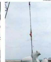
吊り上げ作業 (フックに荷重がかかった状態)
