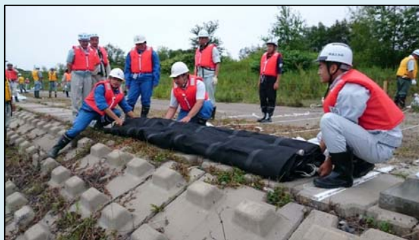
シート張り工実習
