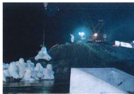
ブロック投入 (S61小貝川災害)
