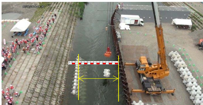
(a) 開口幅約13.0m( 5個投入)
