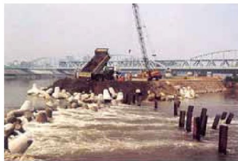
せめ部にH鋼 (S55淀川大堰緊急締切)
