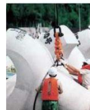
港湾での流石ブロック設置工事 (オートフック15t使用)
