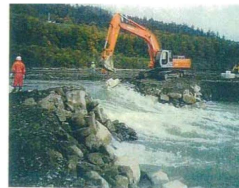
閉塞前の激しい流れ (H14千代田新水路復旧)
