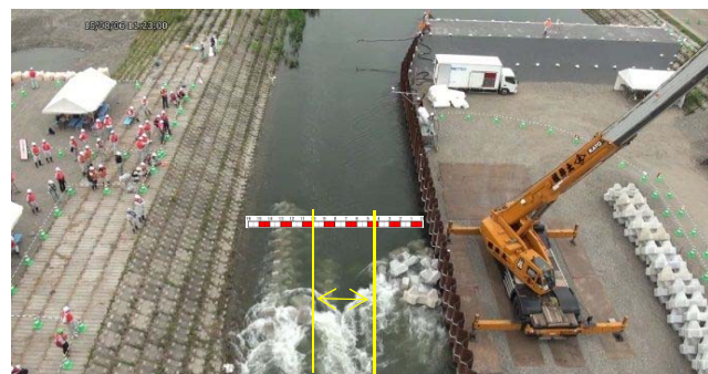
(e) 開口幅約5.5m( 30個投入)
