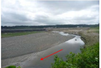
氾濫流の流下による堤内側の洗掘状況
