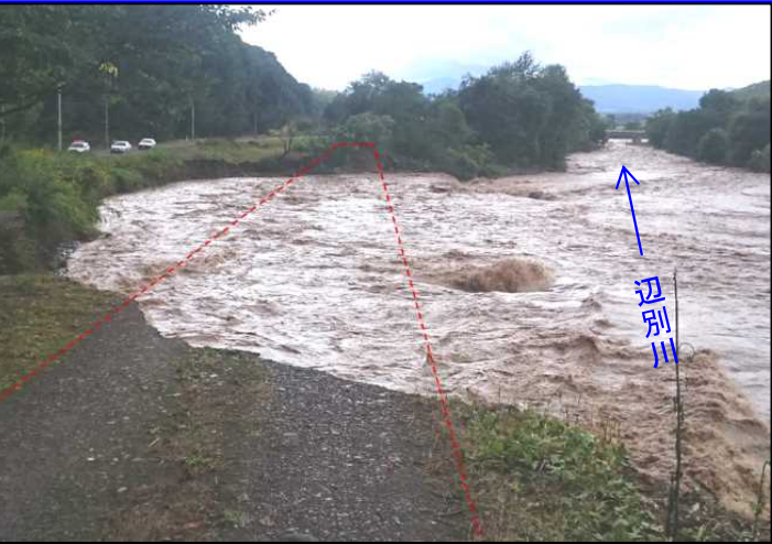
いしかりがわ 石狩川水系辺別川(被害状況)H28.8.23撮影
