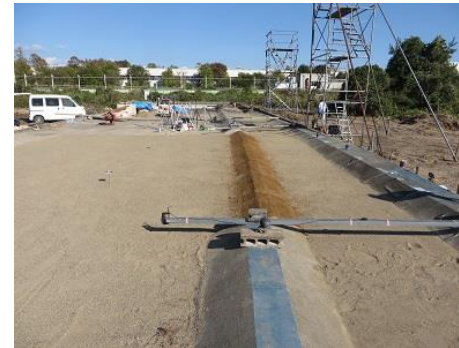
R05.10.26実施 堤体材料：粘性土 基盤材料：砂礫土
