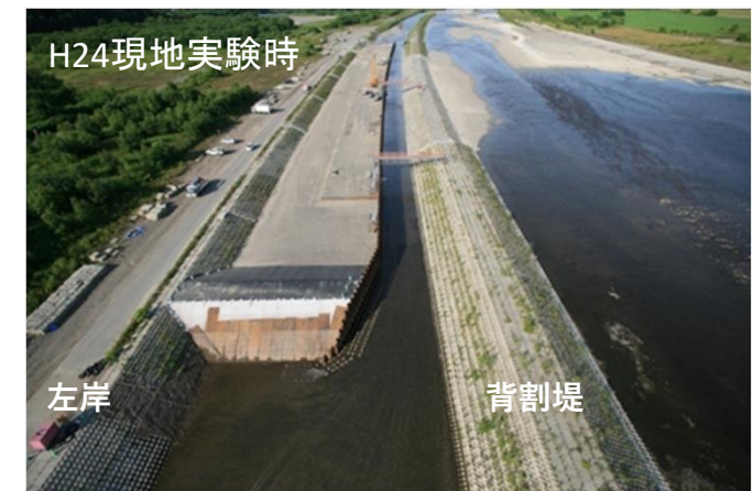
鋼矢板の設置状況
