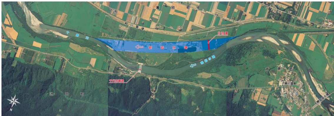
写真-2 千代田新水路全景写真
