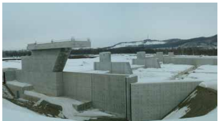
写真-3 千代田新水路の工事状況
