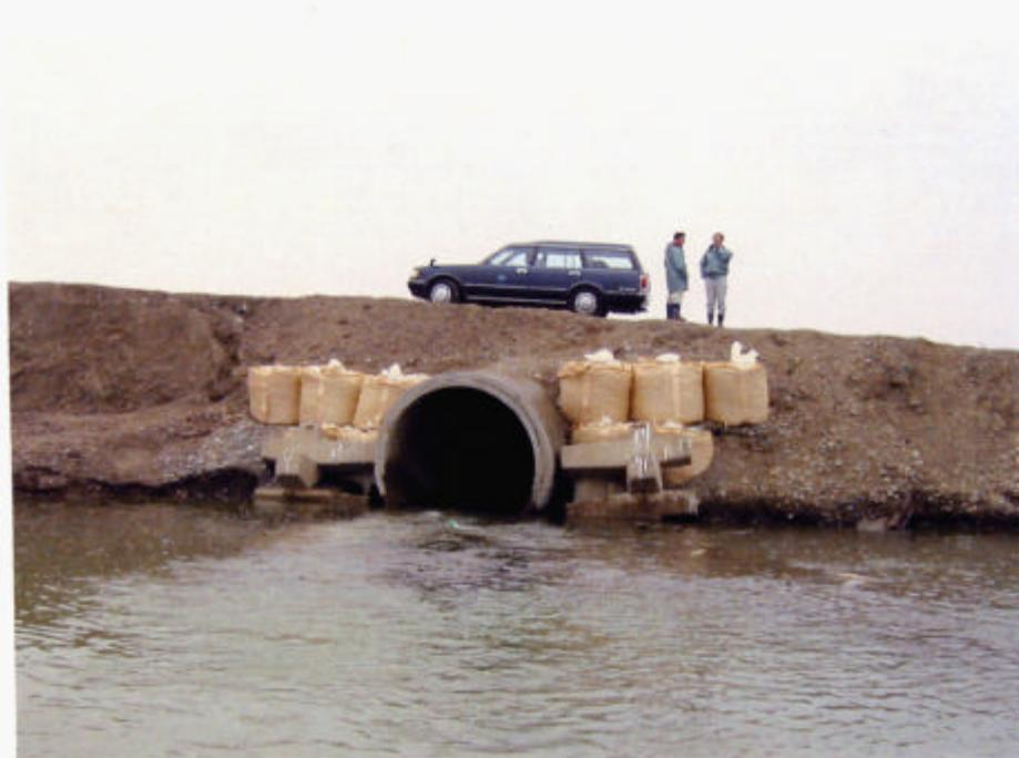
写真 2-6 千代田堰堤連絡路及び水抜き管の設置状況(平成13年11月1日撮影)
