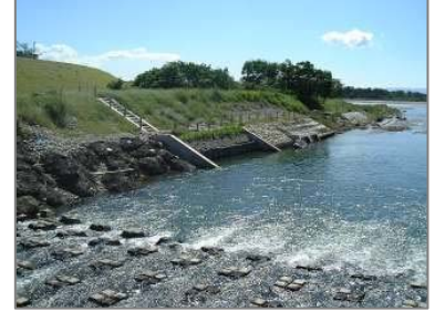
自然共生センター新境川へ設置した保護工の事例
