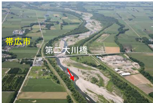
第二大川橋付近
