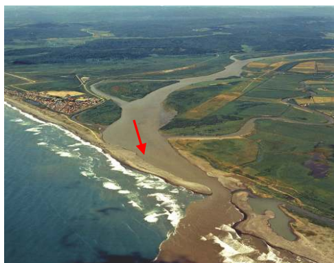
十勝川河口部の状況（昭和 53 年）
