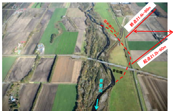
平成 28 年 9 月洪水前の河道形状
