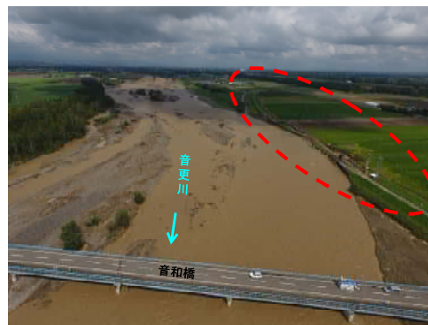
堤防が一部流出（平成 28 年 9 月洪水）
