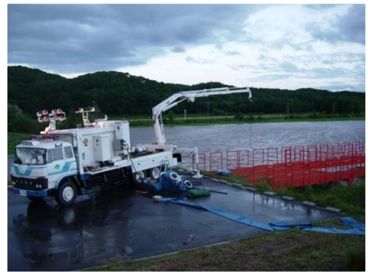
西稲穂第二樋門 （H15 年 8 月洪水）
