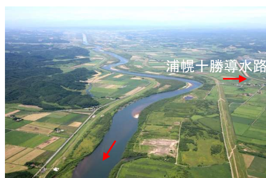
浦幌十勝導水路付近
