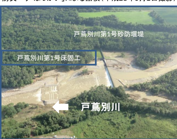
平常時（平成26年7月4日撮影） 砂防施設による土砂の捕捉効果（平成28年9月2日） 砂防施設による土砂の捕捉効果（平成28年9月1日）
