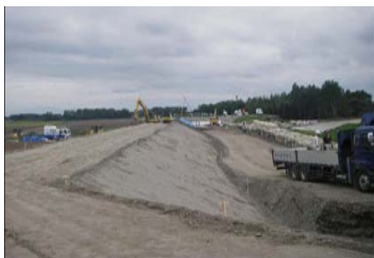
写真3-14 仮堤防盛土状況
