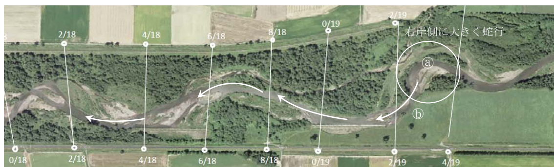
写真 3-10 出水前の状況 (KP19.2～19.6、H22 年 8 月撮影)
