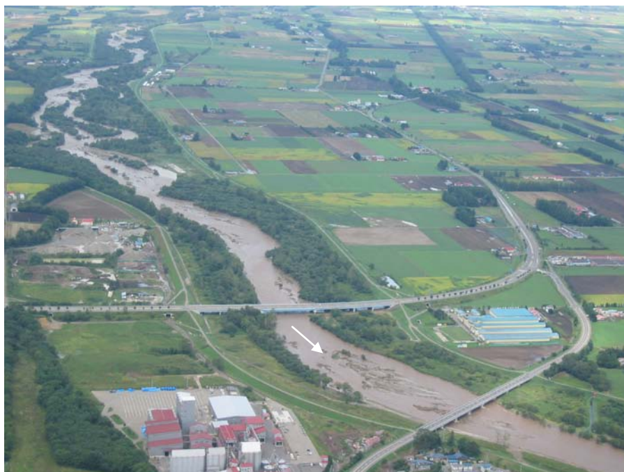
写真3-8 下流側の状況（KP10～15。下流側から撮影。H23.9.7 PM1:42 撮影）
