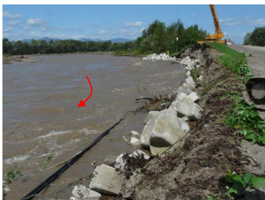
写真3-12 根固めブロック投入状況
