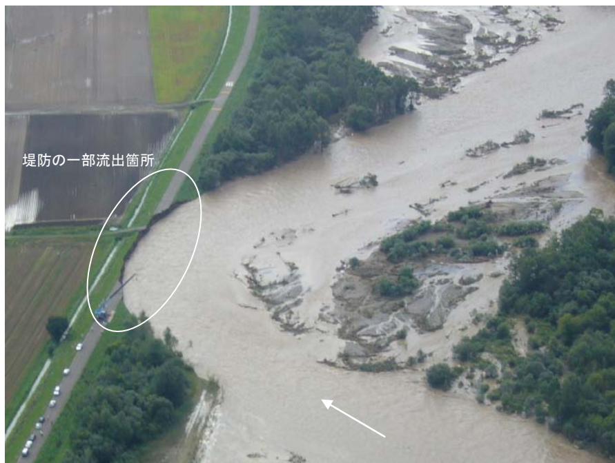
写真 3-5 堤防の一部流出箇所（上流側から撮影。H23.9.7 AM10:38 撮影）
