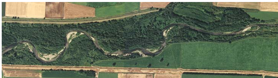
図 5-26 H15 出水前の状況（H12 年撮影、KP18～KP20）
