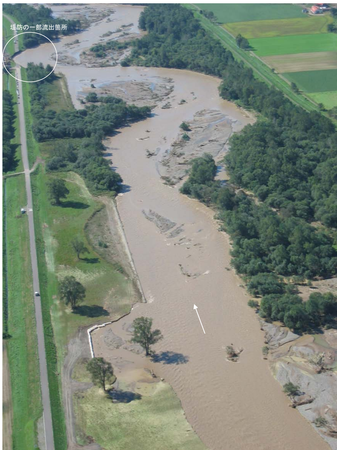
写真 3-6 堤防の一部流出箇所全景（上流側から撮影。H23.9.8 AM10:29 撮影）
