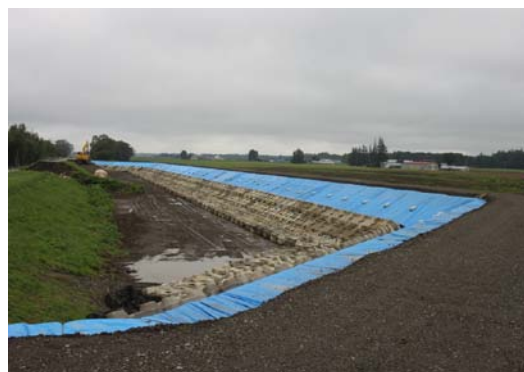
写真3-15 仮堤防完成状況
