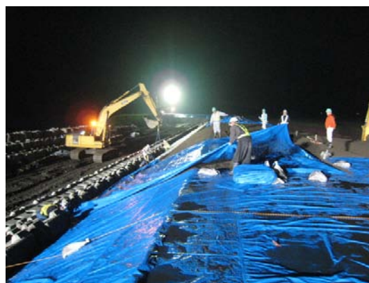
写真3-13 照明車を設置しての夜間作業状況
