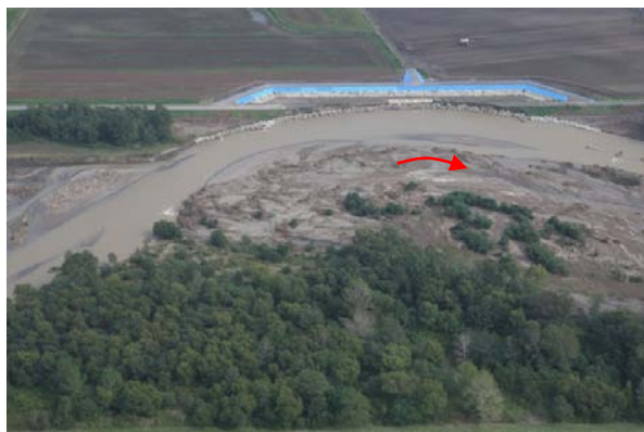
写真3-16 仮堤防完成状況
