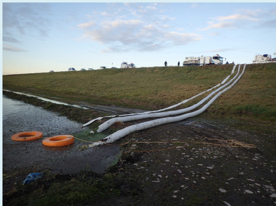
ポンプ排水状況
