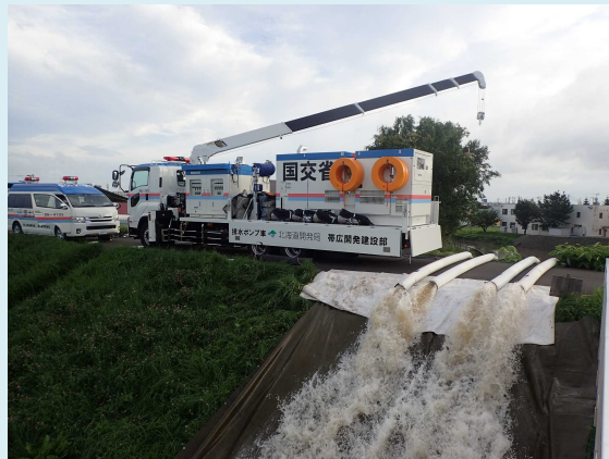
ポンプ排水状況(木賊原樋門)
