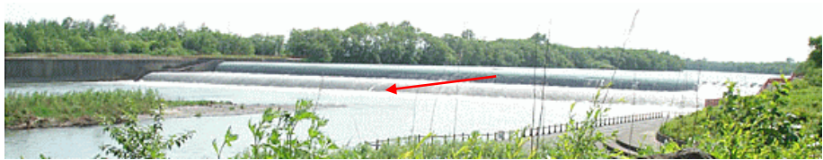
千代田堰堤全景(現在)
