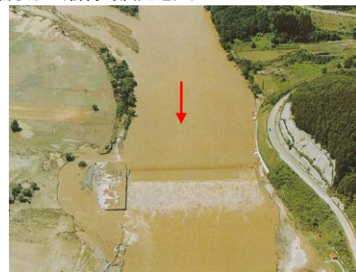
千代田堰堤の被災状況（池田町）
