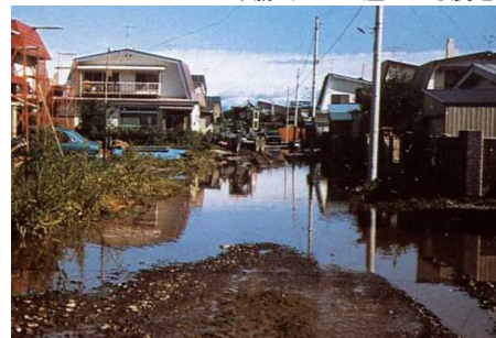
市街地の浸水状況（帯広市）
