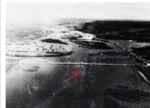
十勝川茂岩橋付近の氾濫状況（豊頃町）
