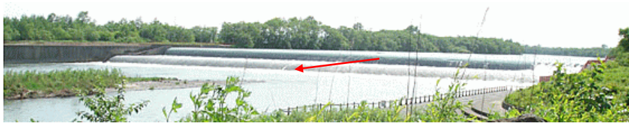
千代田堰堤全景(現在)
