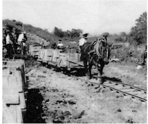
昭和 35 年頃まで馬トロにより土砂を運搬
