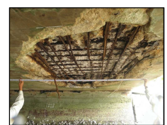
内部の鉄筋が露出した橋梁
