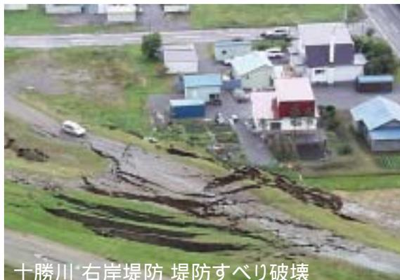
十勝川 右岸堤防 堤防すべり破壊
