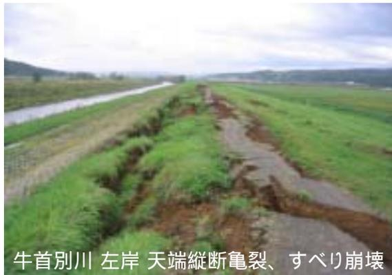
牛首別川 左岸 天端縦断亀裂、すべり崩壊
