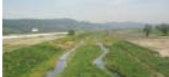
千代田分流堰に整備された水路式魚道
