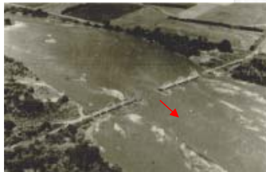
流出した札内川上札内橋（中札内村）
