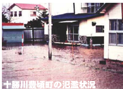
豊頃町市街地の浸水状況
