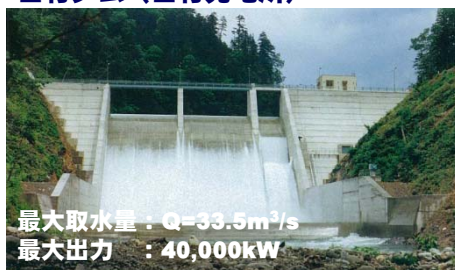
美生ダム（芽室地区）
