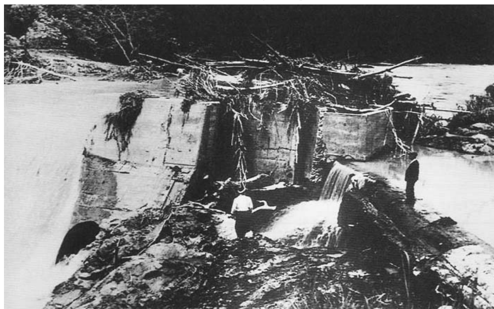
▲ 豪雨による土砂流出により、一夜にして埋没した農業用発電ダム
