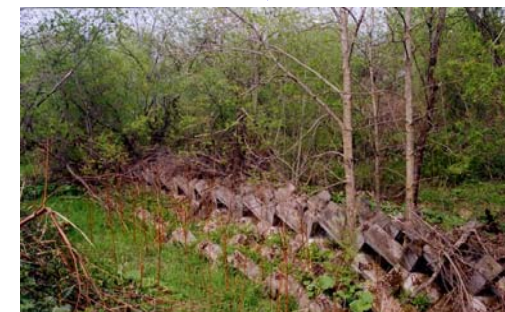
水制工による高水敷化
