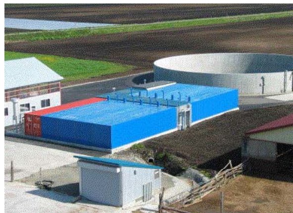
バイオガスプラント（士幌南地区）
