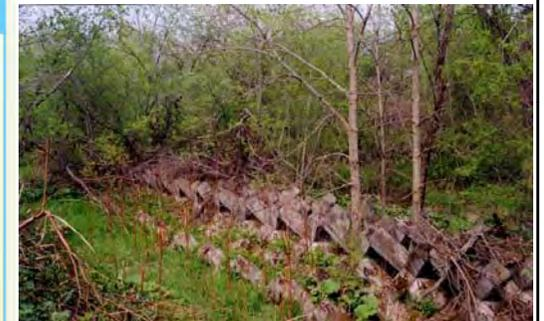
水制工による高水敷化（札内川）
