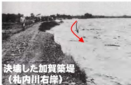
決壊した加賀築堤（札内川右岸）
