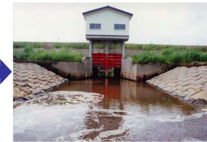
堆積土掘削後
