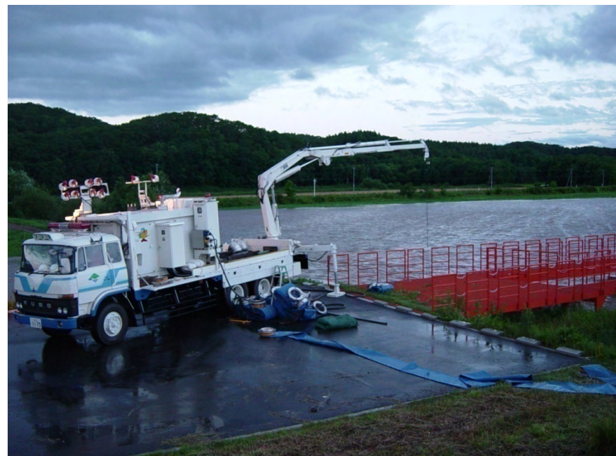
西稲穂第二樋門（平成15年8月洪水）
