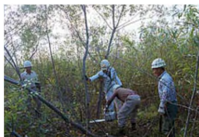
河道内樹木 伐採状況
