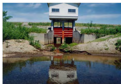
堆積土掘削前
