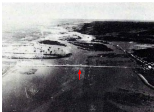
昭和37年8月洪水 十勝川茂岩橋付近の氾濫状況(豊頃町)
