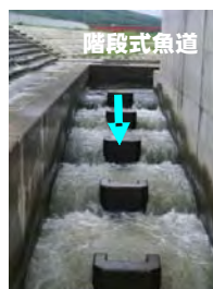
高島頭首工における魚道の設置状況（右岸）
