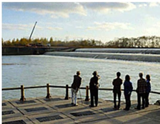
千代田堰堤（池田町）
