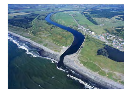
応急的な掘削後
