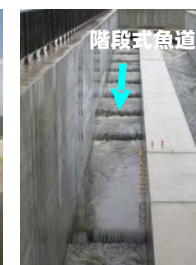
千代田分流堰における魚道の設置状況（右岸）
