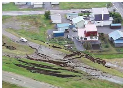
平成15年 十勝沖地震 十勝川 右岸堤防 堤防すべり破壊
