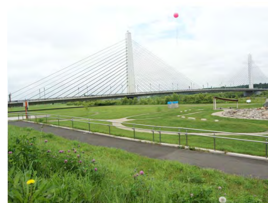
十勝大橋と河川公園（帯広市）
