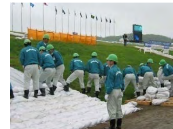
水防公開演習（シート法覆工法）
