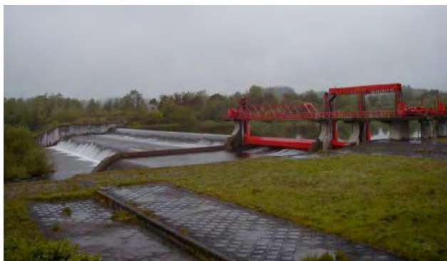
頭首工による取水（十勝頭首工）
