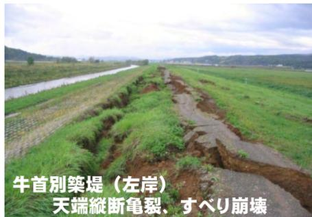
牛首別築堤（左岸）天端縦断亀裂、すべり崩壊
