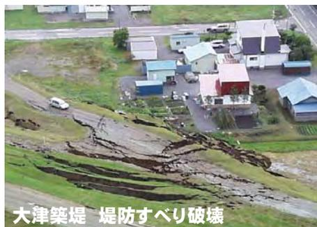
大津築堤 堤防すべり破壊
