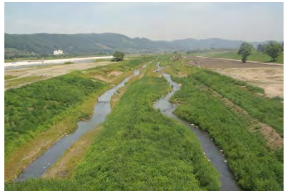
千代田分流堰に整備された水路式魚道
