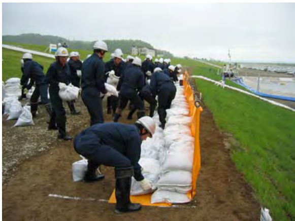
水防公開演習（改良積み土のう工法）
