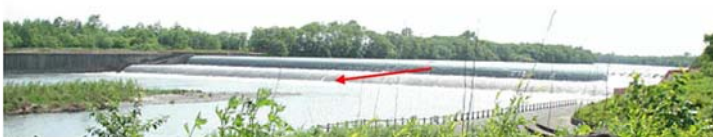
千代田堰堤全景 (現在)
