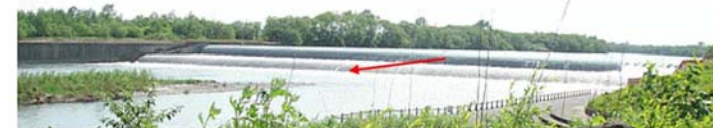
千代田堰堤全景 (現在)
