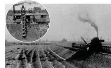
エキスカベーターによる統内新水路の掘削
