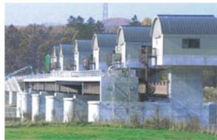
新高島頭首工
