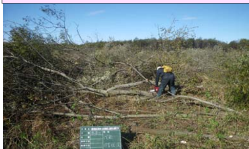
人力での河道内の樹木伐開状況
