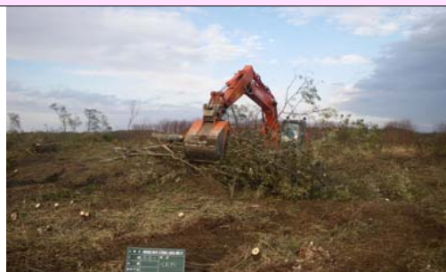
重機での河道内の樹木伐開状況
