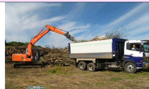
重機での伐木集積・搬出状況
