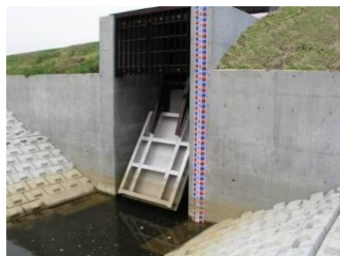
施工例（フラップゲート）
