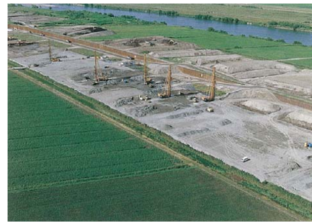
サンドコンパクションパイル工法の施工状況
