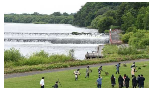
土木遺産に認定された千代田堰堤
