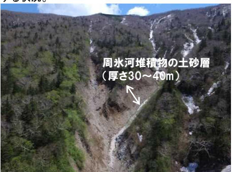
崩壊の発生（戸蔭別川上流）
