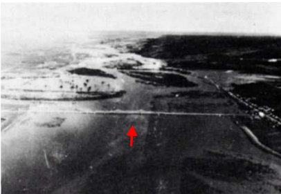
昭和37年8月洪水 十勝川茂岩橋付近のはん濫状況 (豊頃町)
