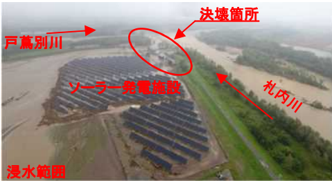
平成28年8月洪水 札内川 戸蔭別川合流付近 決壊後の状況 (帯広市)
