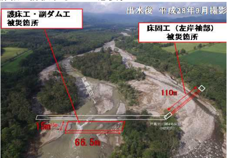
戸蔭別川床固工群の土砂流下状況
