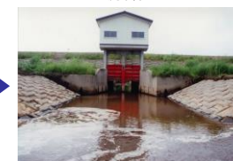
堆積土掘削後
