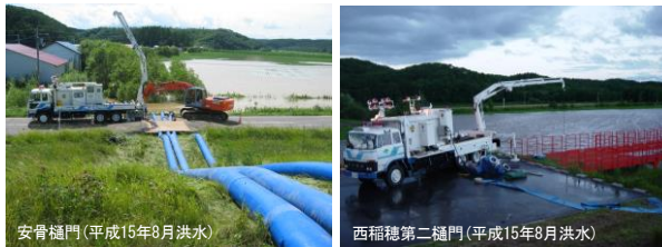
内水排除の状況
