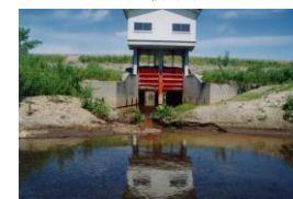
堆積土掘削前
