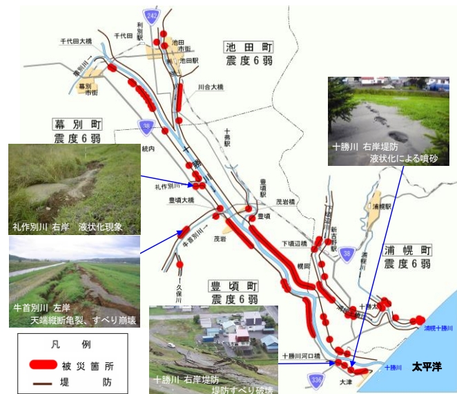
図 1-16 平成 15 年 十勝沖地震 堤防の被害状況
