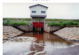
堆積土掘削後
