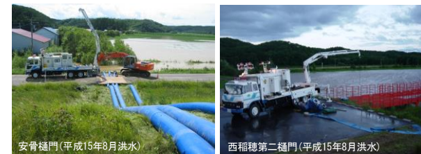
内水排除の状況
