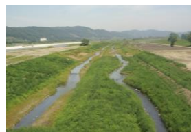
千代田分流堰に整備された水路式魚道
