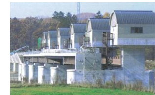
新高島頭首工
