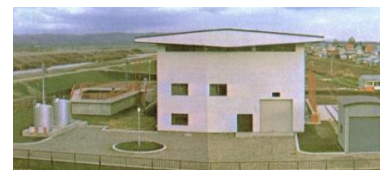
帯広排水機場(帯広川)
