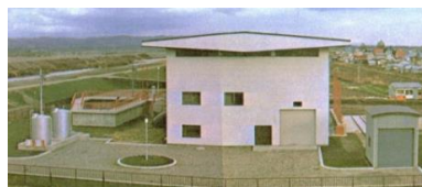
帯広排水機場(帯広川)
