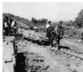
昭和 35 年頃まで馬トロにより土砂を運搬
