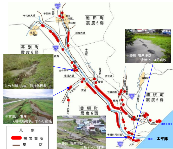
図 1-19 平成 15 年 十勝沖地震 堤防の被害状況
