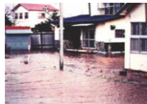
大津市街地の浸水状況（豊頃町）
