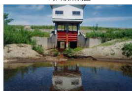
堆積土掘削前
