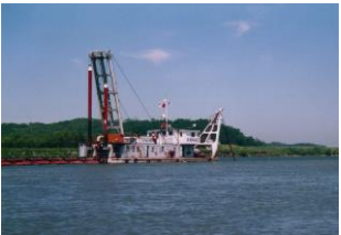
ポンプ船による浚渫
