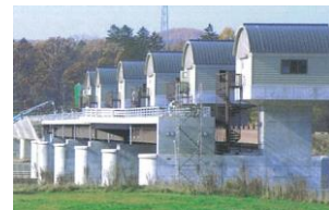
新高島頭首工
