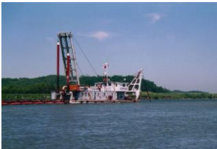
ポンプ船による浚渫
