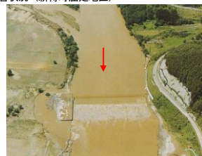
千代田堰堤の被災状況（池田町）
