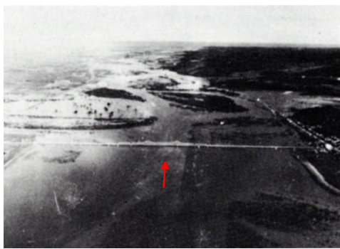
十勝川茂岩橋付近の氾濫状況（豊頃町）
