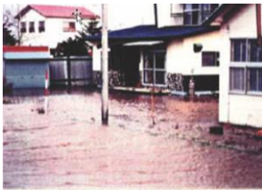
大津市街地の浸水状況（豊頃町）
