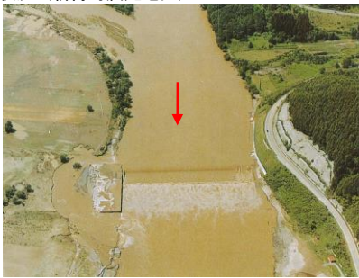
千代田堰堤の被災状況（池田町）
