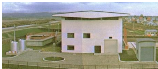
帯広排水機場(帯広川)
