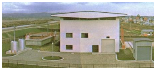
帯広排水機場(帯広川)
