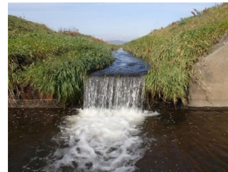
※十勝川新川樋門（KP33.1）
