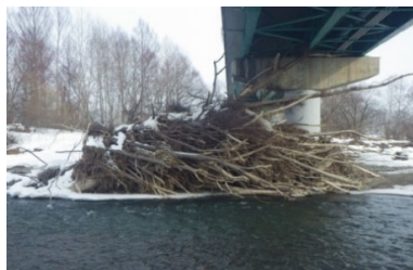
平成28年8月出水後の流木状況
