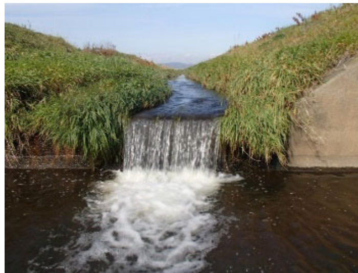
連続性が分断されている例 (特に小支川と本川との連続性が分断され、生息域が限定的なものとなっている)
