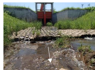
遡上困難な地点の例 (十勝川 新川樋門吐口水路)
