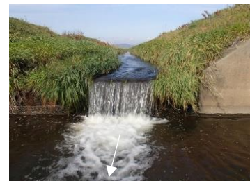
遡上困難な地点の例 (十勝川 新川樋門流入水路)
