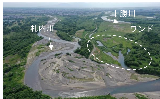
写真 2-2-3 支川流入部のワンド(十勝川)
