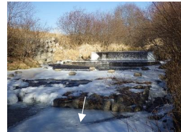
遡上困難な施設の例 (下頃辺川 第2号床止工(全景))
