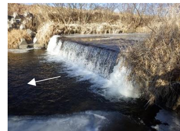
遡上困難な施設の例 (下頃辺川 第2号床止工(近景))
