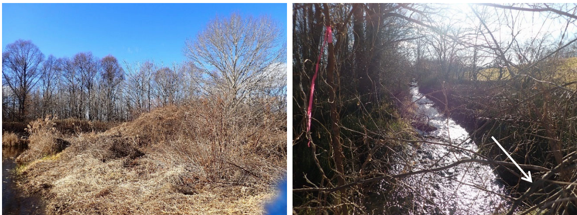
写真 霞堤内の樹木繁茂状況(令和6年)
