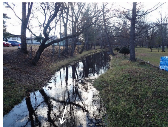
ヌップク川の 震堤上流部の河道状況
