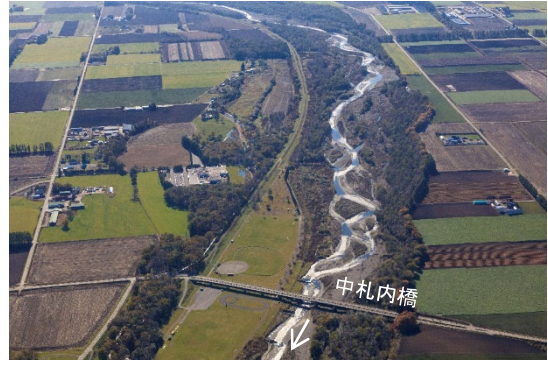
札内川上流部 (KP35 付近, 令和 2 年撮影)
