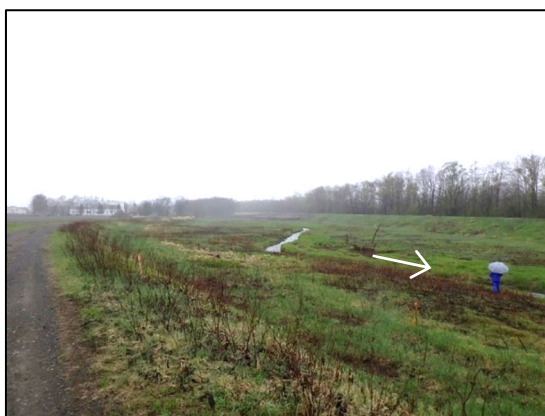
写真 霞堤内の状況(令和 6 年 4 月)
