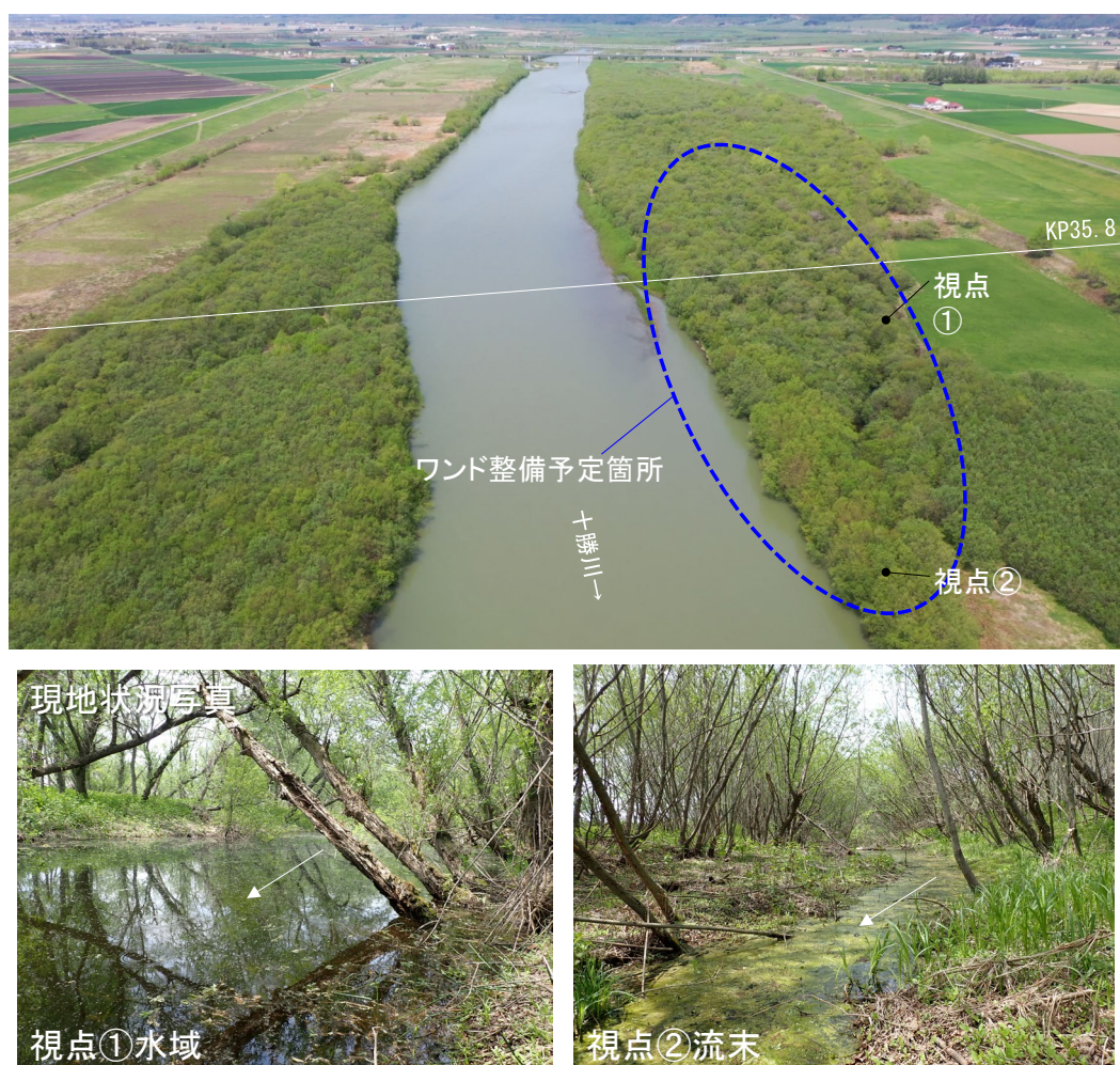
図 4-2-5 ワンド1 (KP35.8 左岸) 整備箇所の現況
