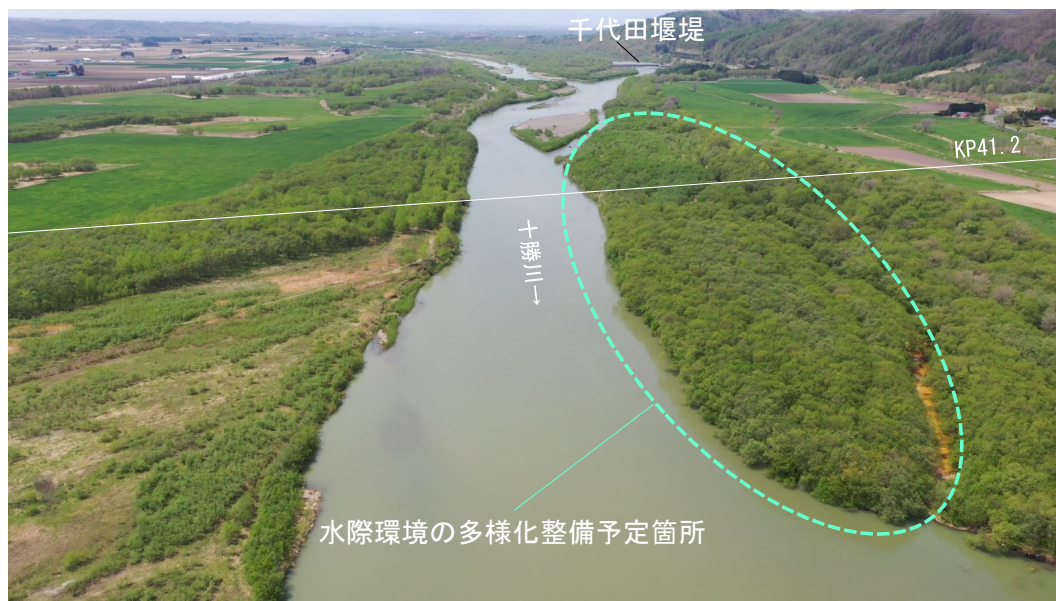
図 4-4-4 砂州尻の浅場緩流域（KP41.2 左岸）整備箇所の現況
