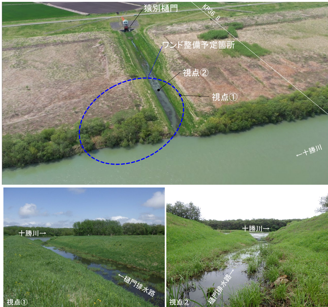
図 4-2-13 ワンド3 (KP36.7 右岸) 整備箇所の現況
