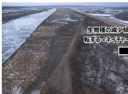
河道内に整備した湿地環境
