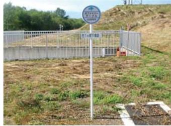
光ファイバーケーブルの埋設表示板
