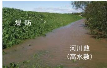
堤防により河川敷に洪水を流せる
