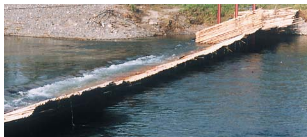
人工ふ化のためにサケを捕獲するため設置された「ウライ」（猿別川）
