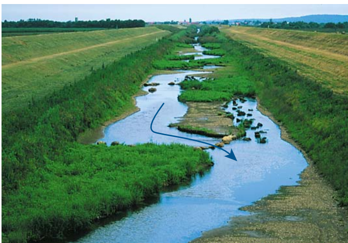
洪水の時にはまっすぐ流れ、水が少ない時には曲がって流れるように工事をした川。下頃辺川(浦幌町)。
