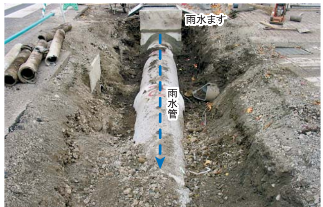
(上) 水は地下のパイプ＝雨水管を流れていく。 (右下) 雨水管がうめられたあとの歩道。
