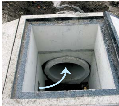
雨水ます。落ち葉などをしずめ、雨水管に水を送る。
