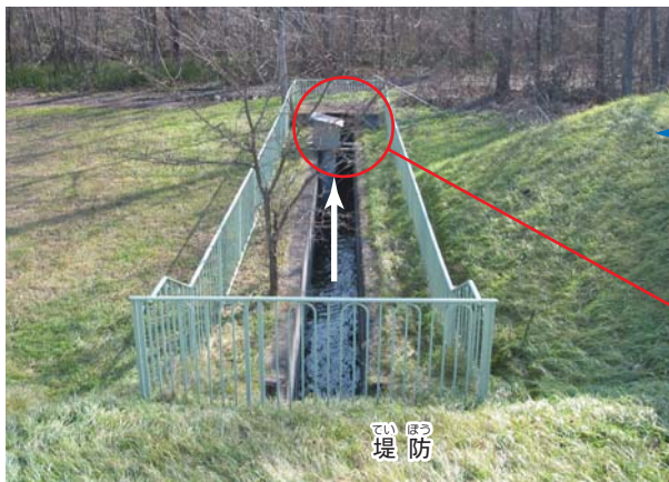
樋門をくぐって出た水は用水路に向かう。
