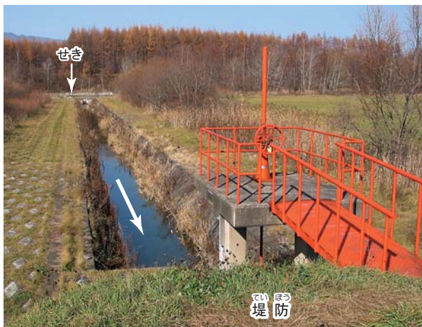
引きこまれた水が堤防に向かう。
