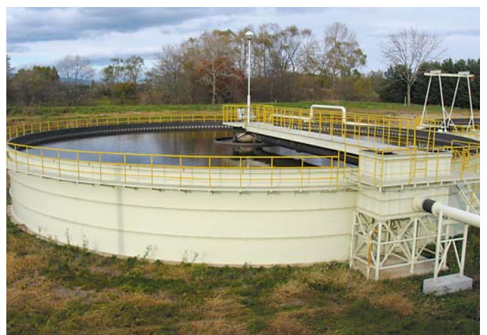
微生物(びせいぶつ)がしずみやすい固まりとしたよごれを、沈(ちん)でんさせる池。
