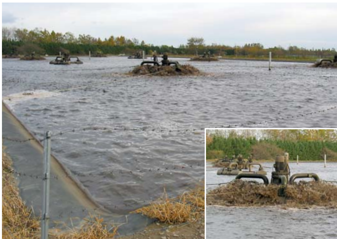
微生物(びせいぶつ)によって排水(はいすい)をきれいにする池。右下は、微生物(びせいぶつ)のために空気を水に送りこんでいる(ばっ気=エアレーションという)ところ。
