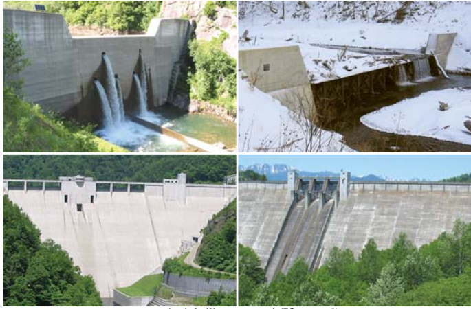
いろいろなダム。左上が戸蔭別川第8号砂防えん堤、右上が、ポントムラウシ川の砂防えん堤、左下が札内川ダム、右下が糠平ダム。
