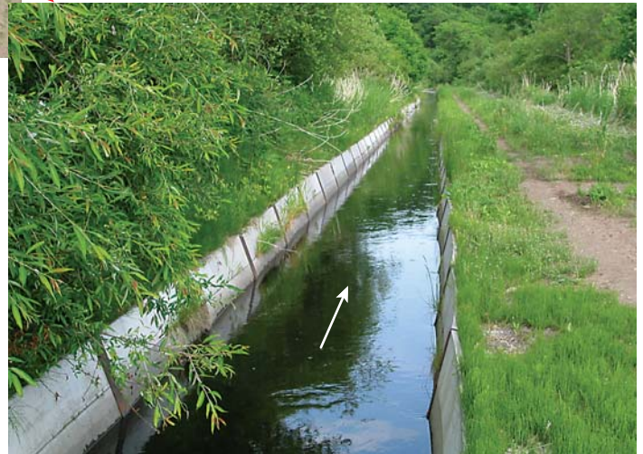
小段(左上写真)の上にある水路。ほぼ平らに水路が続いている。
