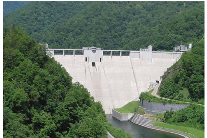
さつないがわ 札内川ダム。このダムは、農業用水のほか水道や発電のためにも水をため、また洪水の被害を減らすなどいろいろな役割を持っている。(→ p20、p36、p52)
