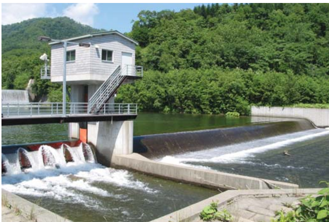
さつないがわとうしゅこう 札内川頭首工。せきで水位を上げ水を引きこむ。
